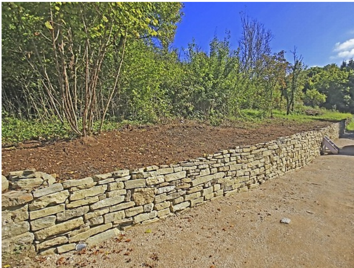
Ein Blick auf die wieder aufgebaute Weinbergmauer in Gräfinthal. Foto: Günter Maier
